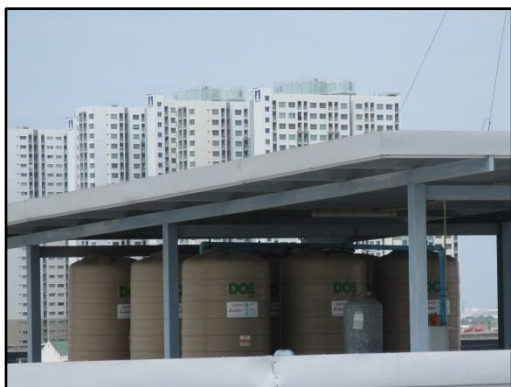
รูปที่ 1-4 ถังเก็บน้ำชั้นดาดฟ้า
